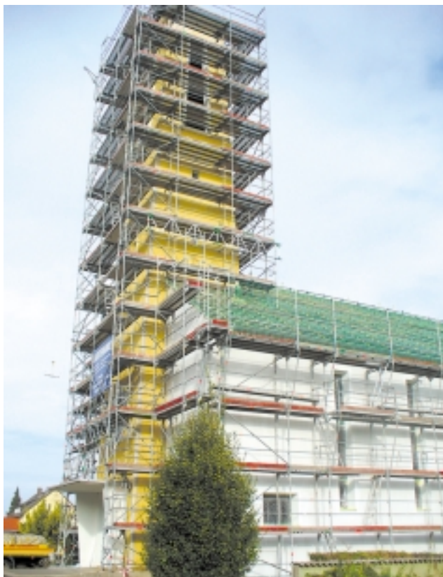
Die eingerüstete Kirche im Herbst 2009
